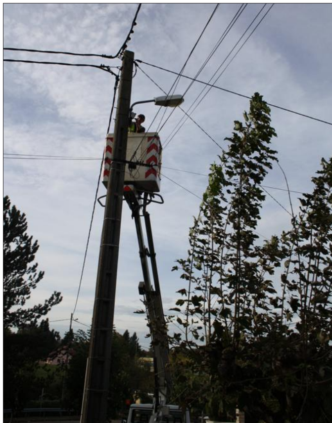
■ L'électricien Xavier Tribillion a pris de la hauteur pour changer cinquante lampadaires.
